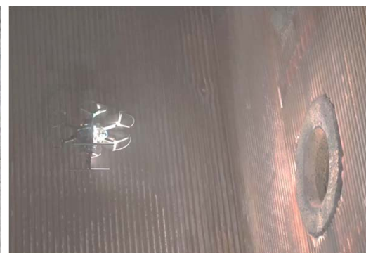
ボイラ炉内点検画像
