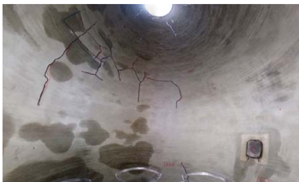
全天球カメラ撮影画像 (煙突内部)
