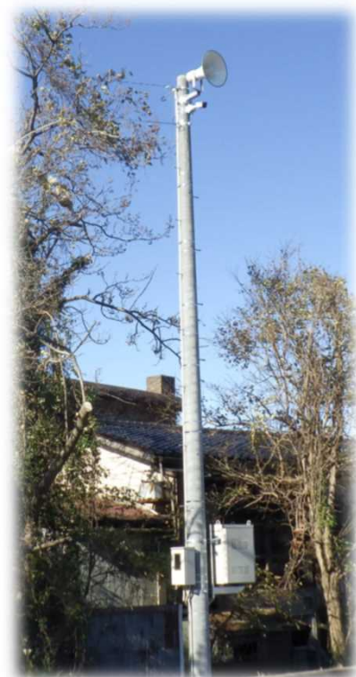
システム設置状況 (カメラ、スピーカ、システム収納BOX)
