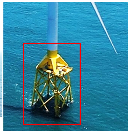
ジャケット気中部、プラットフォーム （赤枠部）
